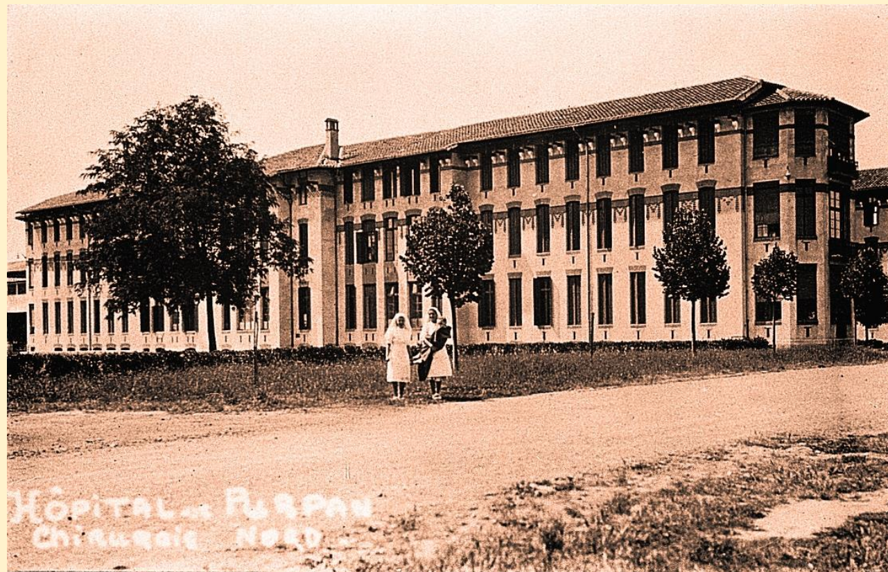
Bâtiment chirurgie nord, 1940
