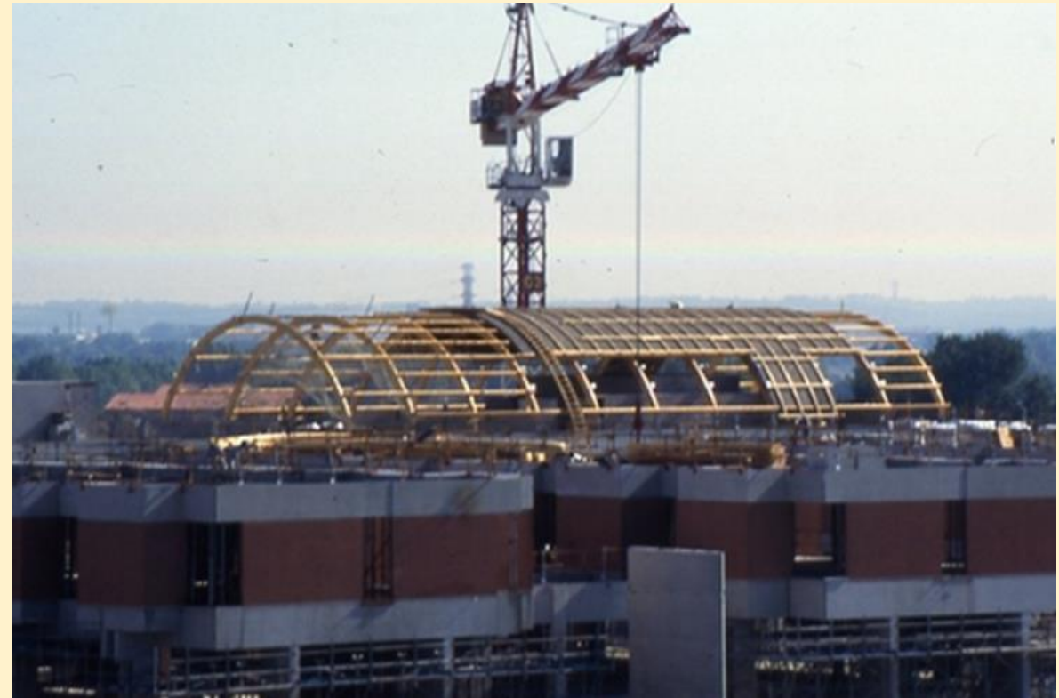
Chantier de l'Hôpital des Enfants, 1995-1996. Coll. Privée
