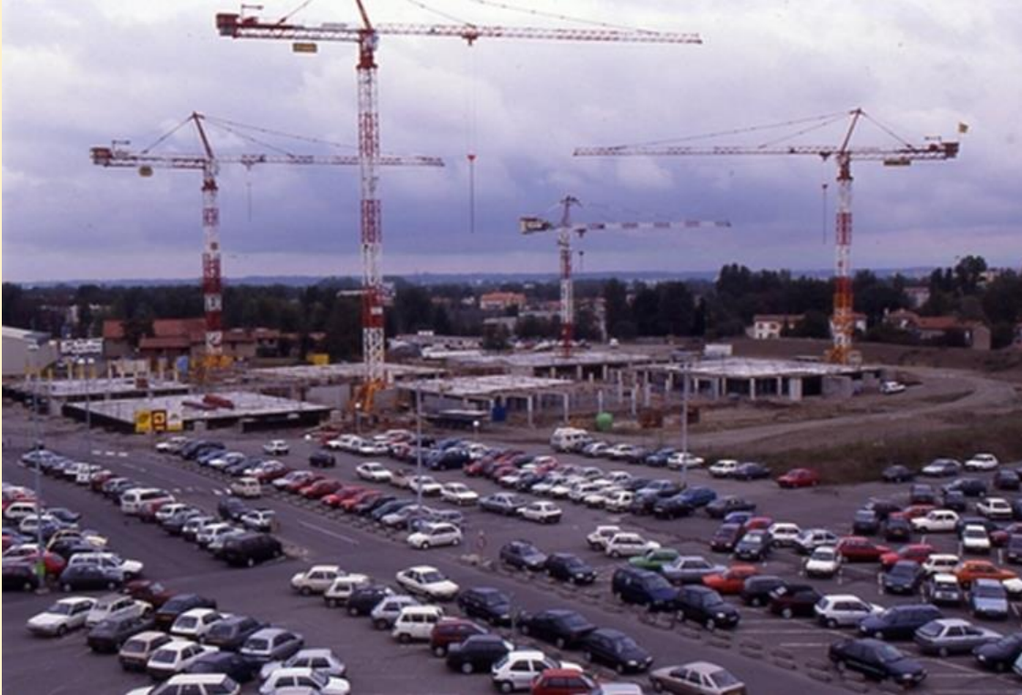
Chantier de l'Hôpital des Enfants, 1995-1996. Coll. Privée
